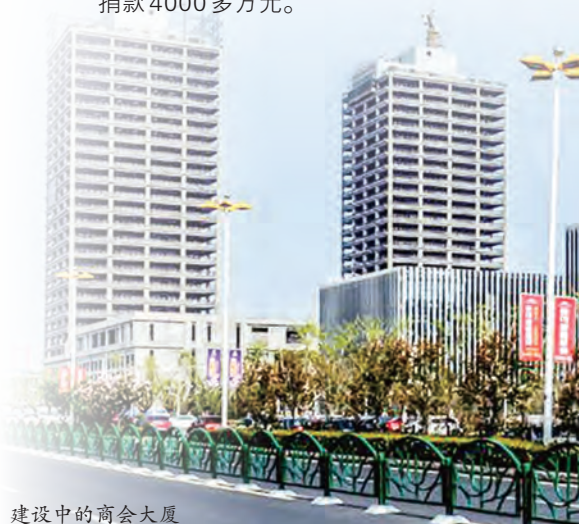
建设中的商会大厦
