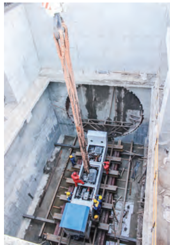
轨道交通4号线吴江段盾构现场
