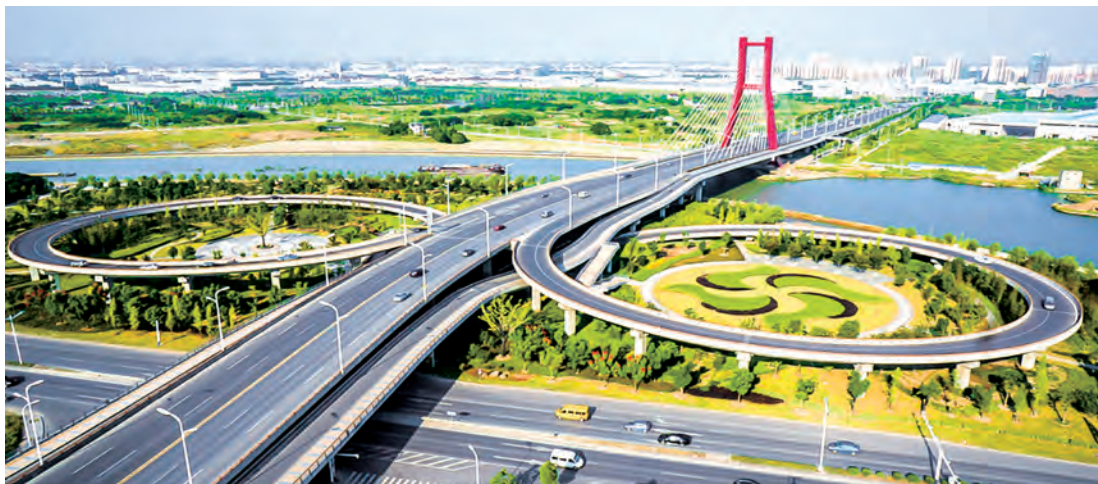
吴江经济技术开发区运河大桥全景
