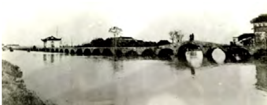
民国4年(1915)整修后的垂虹桥无栏杆
