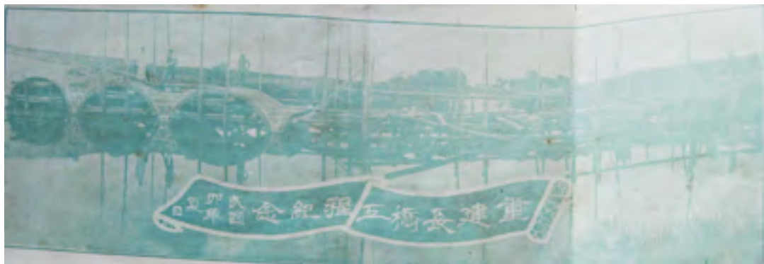
民国 4 年（1915）重修长桥现场
