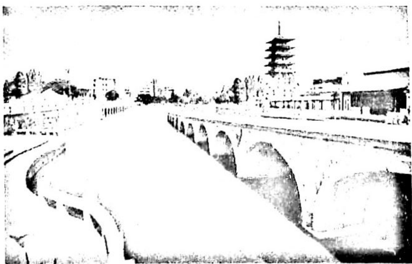
修复后的部分垂虹桥
