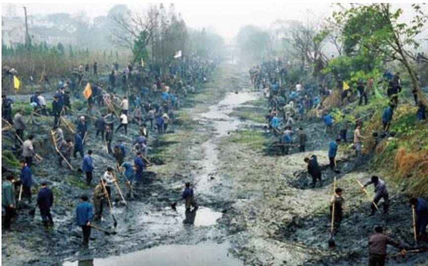
2004年初冬,正在进行的农村河道清淤工程
