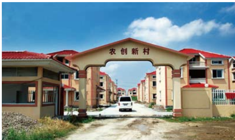
2007 年春,正在建设中的农民集中居住区
