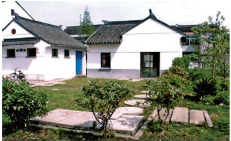
农村生活污水处理设施(摄于2008年夏)
