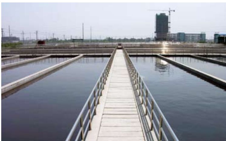
2003 年 5 月 18 日，日处理 5 万吨的污水处理厂在盛泽镇投入运行
