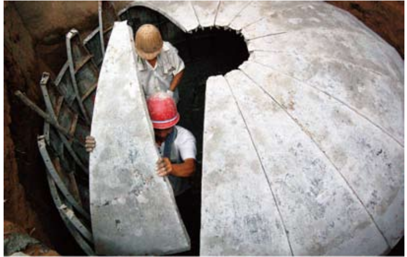
正在建造的沼气池(摄于2001年)
