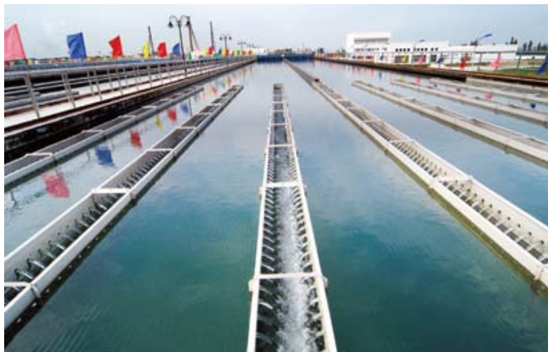
2005年2月,吴江市净水厂一期工程竣工
