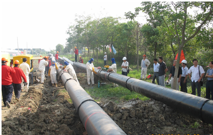
天然气高压管道施工现场
