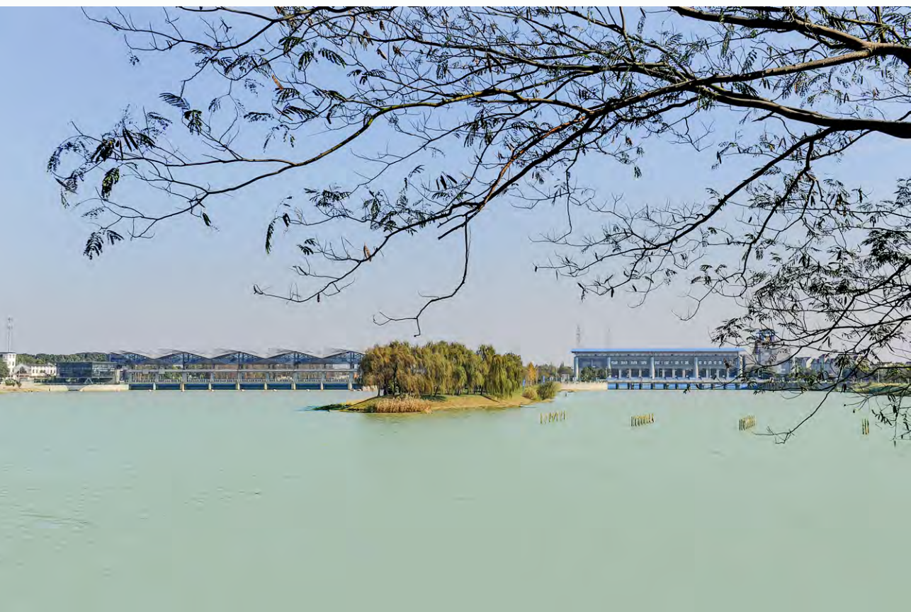
太浦河节制闸与泵站
