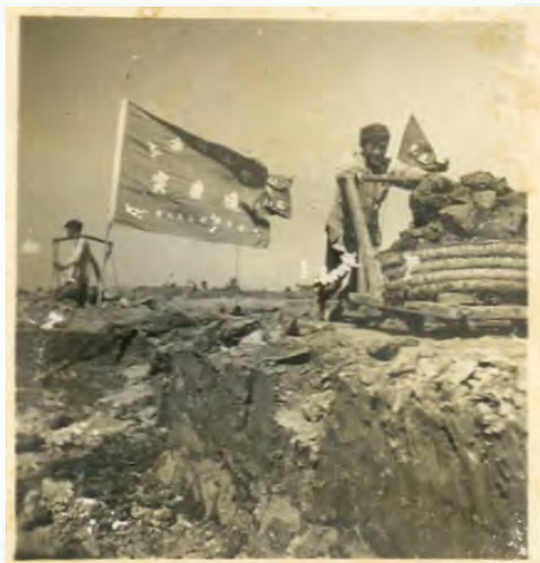
民工在工地(吴江区档案馆提供)
