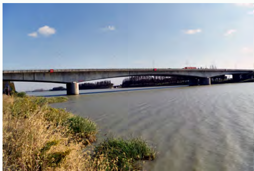
苏震桃公路太浦河大桥
