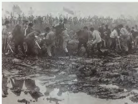
干部群众合力啃下太浦河（上海段）工程中硬骨头 （青浦区档案馆提供）
