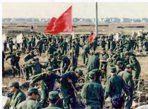
1991年11月，太浦河（上海段）开挖场景（青浦区档案馆提供）
