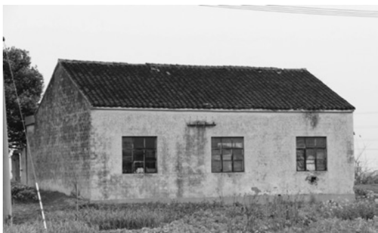
1995年建成的西草田自来水厂厂房(2010年摄)
