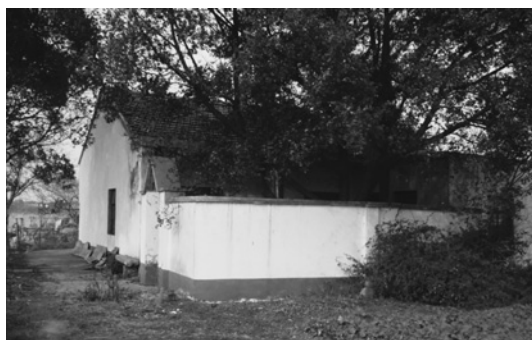
1998年移建的开弦弓村自来水厂厂房(2010年摄)
