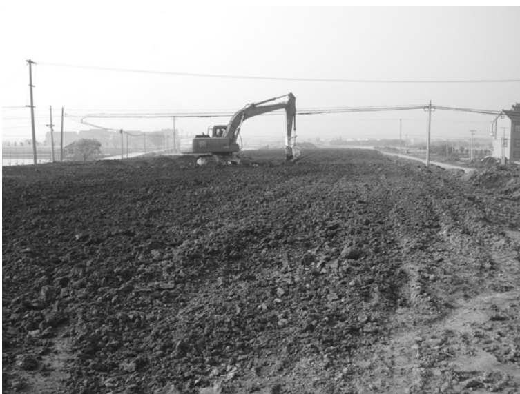
建设中的苏震桃公路(2009年摄)
