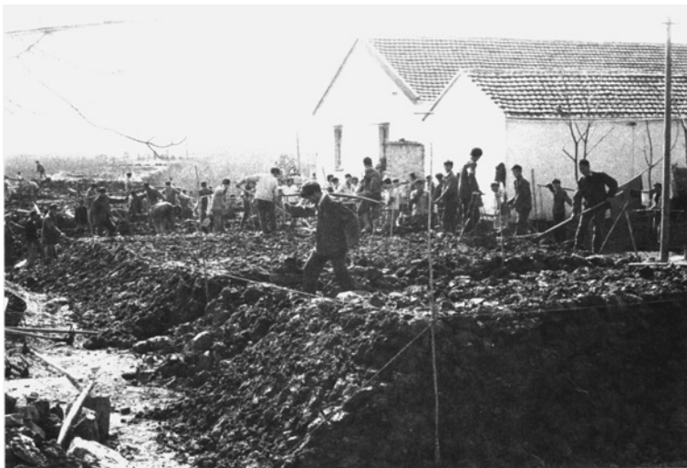
建设中的庙震公路(1982年摄)
