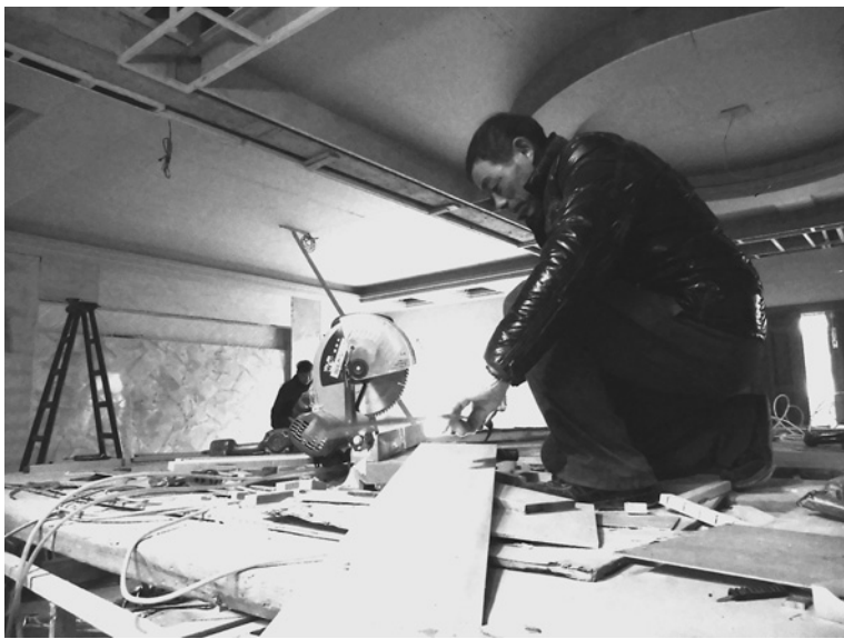
第7村民小组木匠师傅吕龙兴为房屋装修做吊顶(2014年摄)
