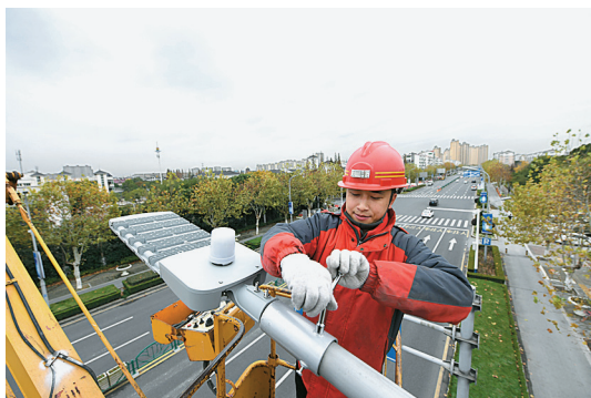
智慧路灯改造 (吴斌 摄)
