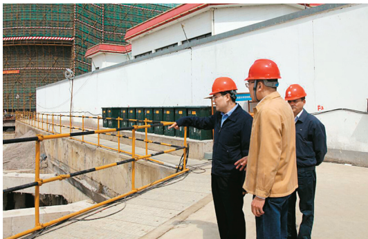
地下管线安全生产检查
