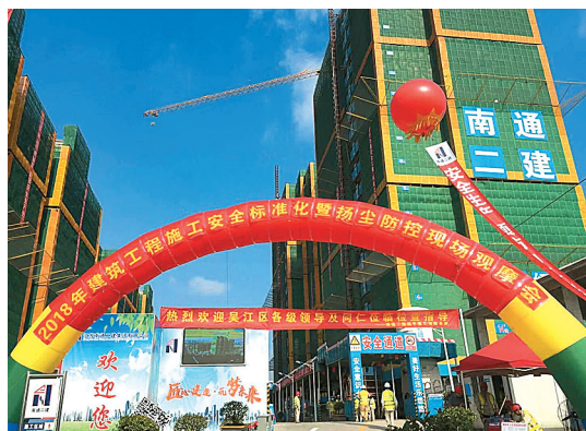
建筑工程施工安全标准化暨扬尘防控现场观摩会 (区住建局 提供)
